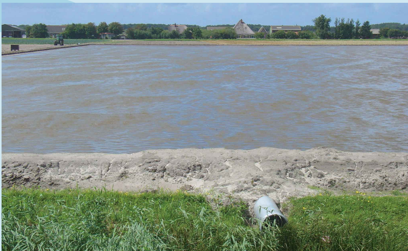
Overloop met lange pijp om dijkdoorbraak te voorkomen
