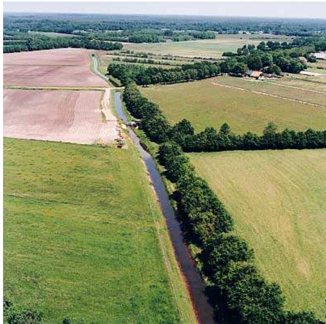
Vledder Aa net voor beekherstelmaatregelen; rechtgetrokken met standaard profiel en stuw
