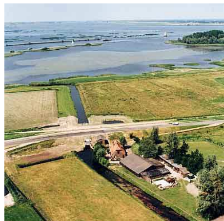
Gemaal Barsbeker Binnenpolder
