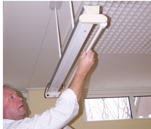
Onbouwen van bestaande armatuur met een energiezuinig voorschakelapparaat
