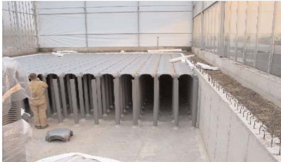
Figuur 10: Kelders in aanbouw; in dit geval als gietwaterbassin 23 .
