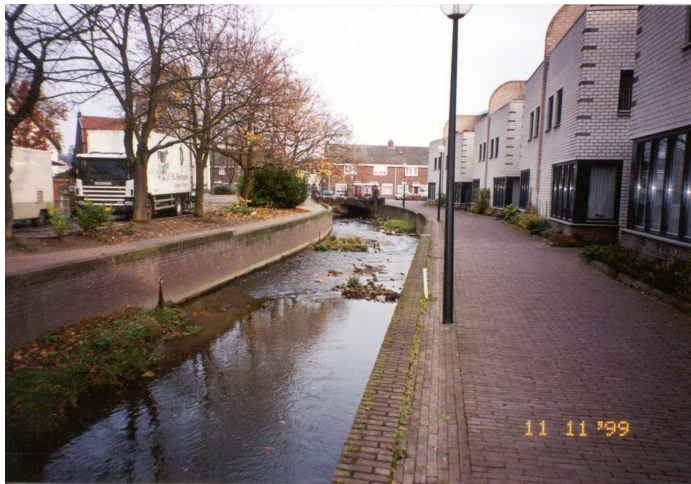
Figuur 6: Aanpassingen in de Gulp te Gulpen om de variatie in stroomsnelheid te vergroten en nestgelegenheid te creëren voor watervogels, zoals ook toepasbaar in de Geul te Valkenburg (foto: R. Barendse).
