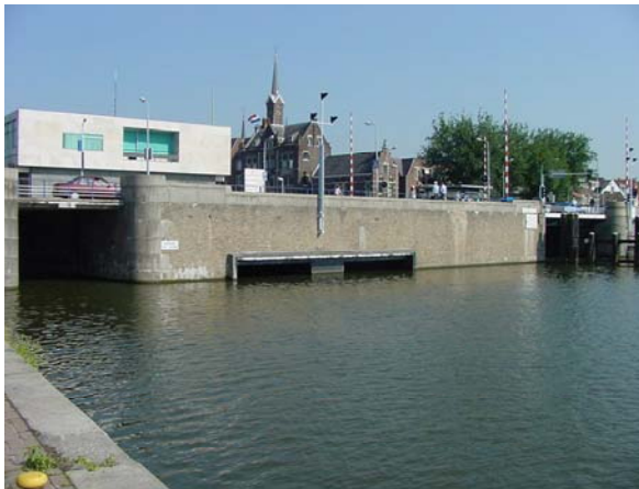
Aanzicht uitstroom van het Zaangemaal
