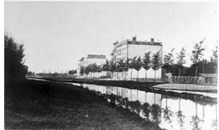
40. Aan de singels van het Waterproject verrezen fraaie villa's, maar de bewoners van de singels moesten tot hun schrik ervaren dat deze hoofdafvoer van het stedelijk rioolstelsel niet helemaal aan de verwachtingen beantwoordde. De stank was er veelal ondraaglijk (foto Gemeentearchief Rotterdam).
