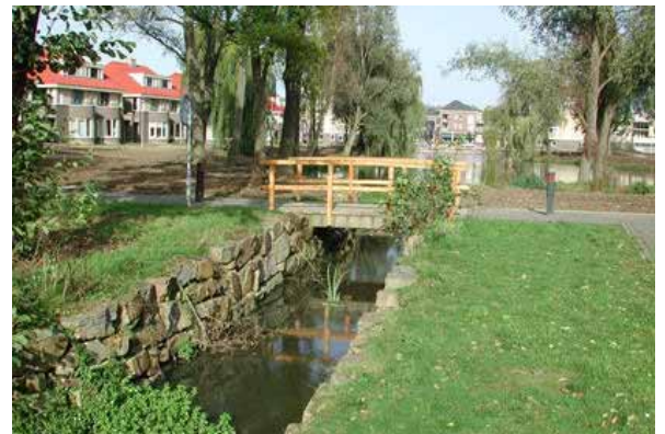
Multifunctioneel water in de bebouwing: voorkomen van wateroverlast, vergroting belevingswaarde, recreatief medegebruik en ruimte voor natuurlijke begroeiing
