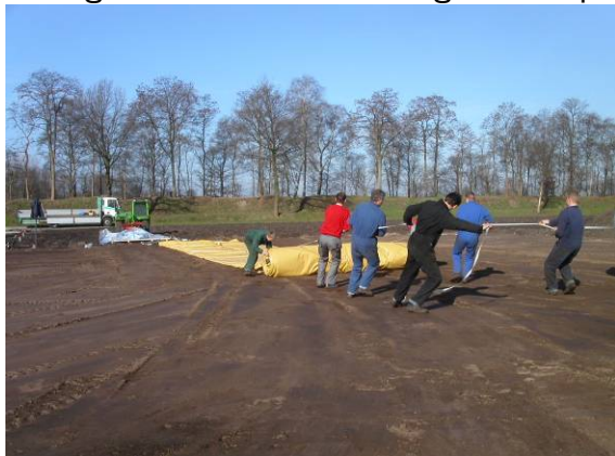
Aanleg waterzak (maart 2005)
