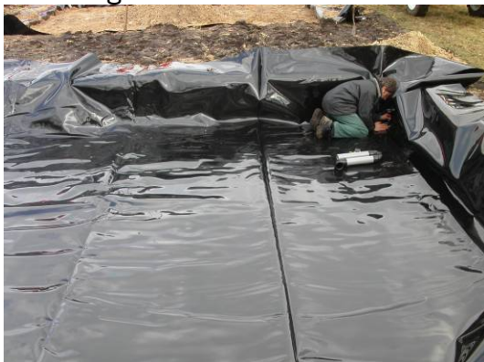
Aanbrengen afdichtingsfolie
