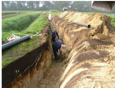
Aanleg bypassbuis langs referentiesloot
