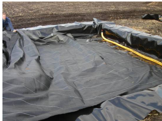
Aanbrengen anti-worteldoek.
