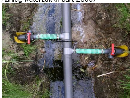
Aansluiting drains op verzameldrain
