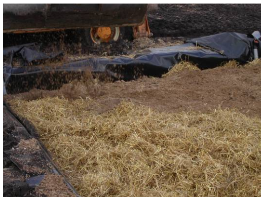
Het aanbrengen van stro en zand
