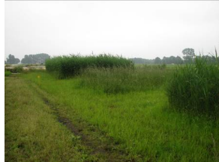
Vloeveld – strofilter – horizontaal filter
