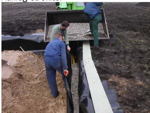
Het vullen van de instroomopening met zand
