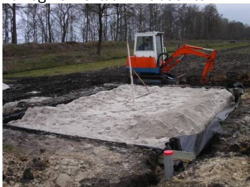
Het vullen van het filter met metselzand
