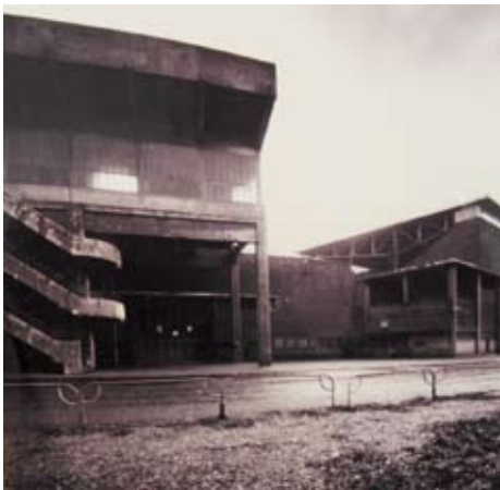
In 1991 werd het stadion gerenoveerd. Op dat moment was het erg vervallen. Omwonenden noemden het misprijzend 'de Pisbak van Roffel', naar de toenmalige directeur.
