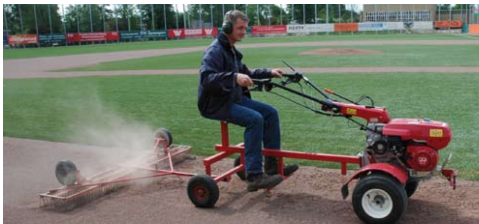
Onderhoud van de halfverharding in het nieuwe honkbalstadion. Op de achtergrond is de cirkel- en hoekvormige maatvoering van het honkbalveld te zien. Uitvoerder Oranjewoud Lutzen Jongema: "Wat zo bijzonder is aan een honkbalveld vergeleken bij een kunstgras voetbalveld, is dat de maatvoering erg complex en streng is."
