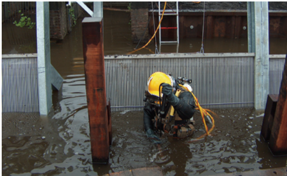
Een duiker last onder water de zeven op de metalen damwand ▲
