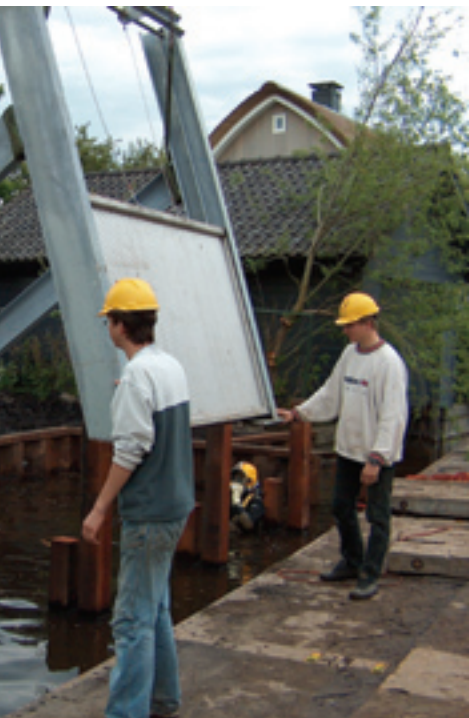
▲ De schuin staande zeven worden in het water geplaatst
