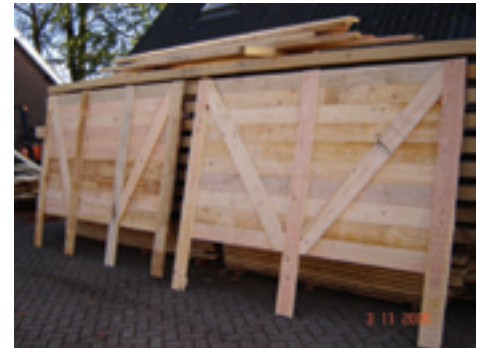
De houten schotten moeten zorgen voor het herstel van de legakkers
