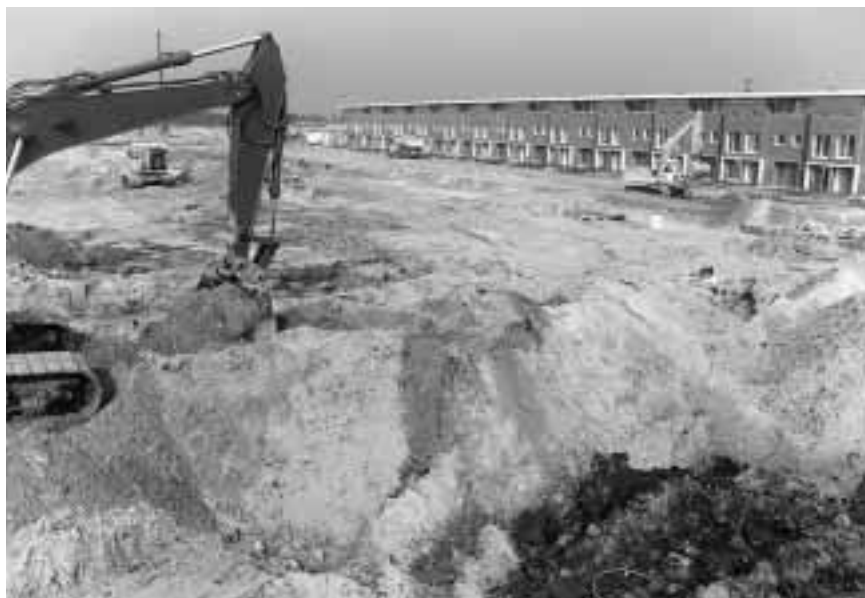
Een goed soortenbeleid kan voorkomen dat in een laat stadium bouwprojecten op last van de rechter worden stilgelegd. Foto: Lex Broere.
