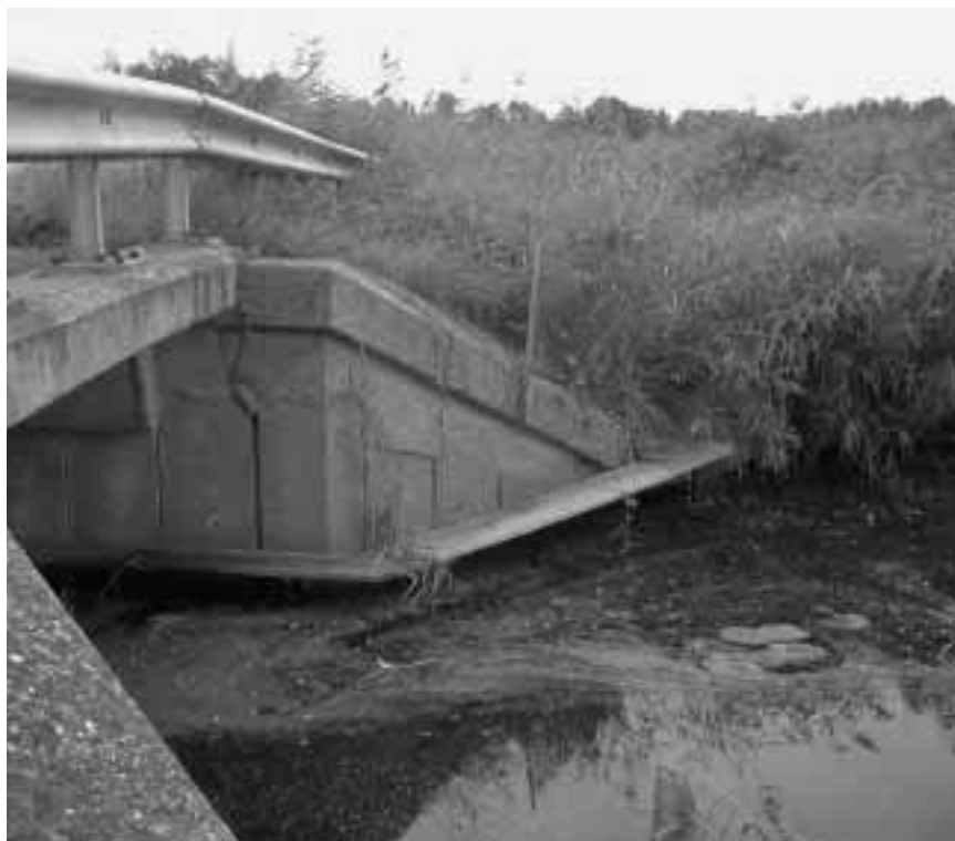
De provinciale weg nabij het natuurgebied Rottige Meenthe bij Wolvega is voorzien van een aantal faunatunnels, rasters en loopplanken bij bruggen voor de otter en andere diersoorten. Foto: M. Wesselius.
