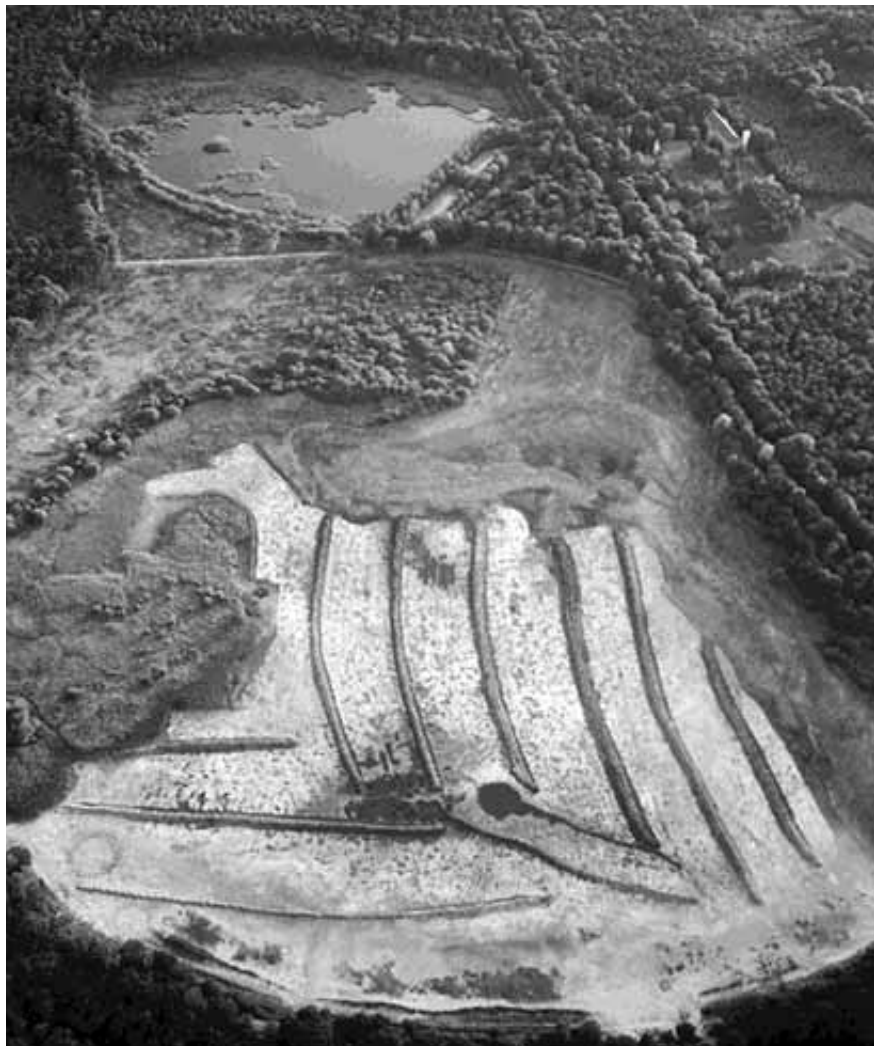
Opschoningswerk in uitvoering. Op de voorgrond Het Groot Meer. Slib is in rillen gelegd om vervolgens af te voeren. Links achter is bos verwijderd om de "strijk lengte" op het water te vergroten. Links komen stukken met waardevolle vegetaties voor. Deze stukken blijven zitten (zaadbank). Op de achtergrond Het Klein Meer. Rechts van de weg Vessem-Wintelre het pompstation van de WOB. Foto: J. van de Berkmortel.
