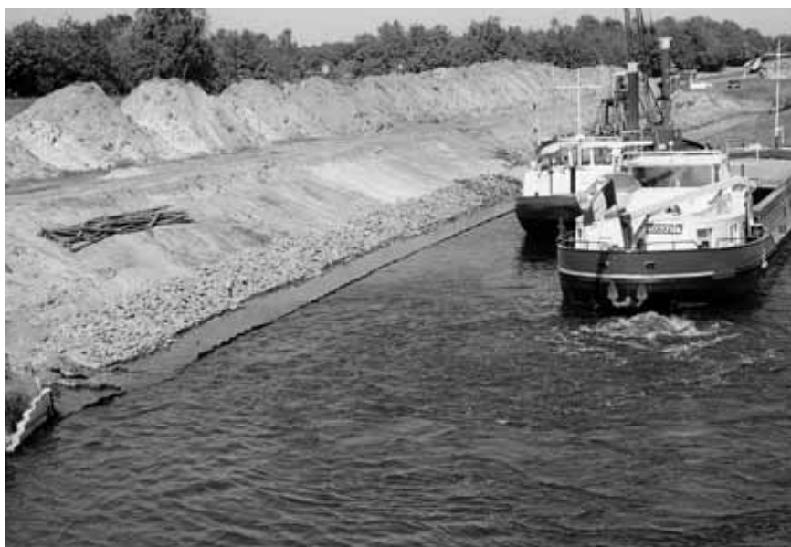
De aanleg van een natuurvriendelijke oever bij Hoogeveen in volle gang. Foto: J. Wiebring.
