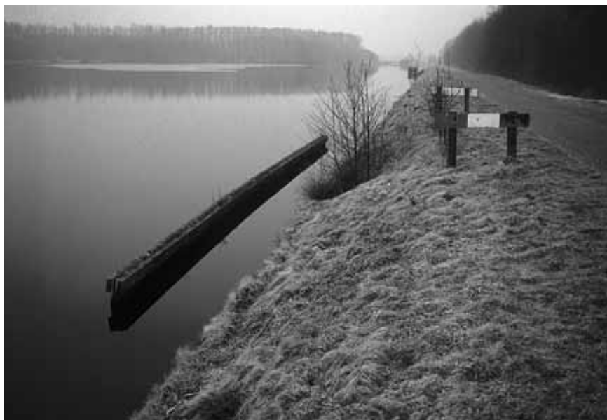
De fauna-uittreedplaats bij het Drentse Yde heeft al wat reeën gered van de verdrinkingdood. Achter de vooruitgeplaatste damwand is de bodem verhoogd, waardoor reeën het water uit kunnen wandelen. Foto: Hans Dekker.
