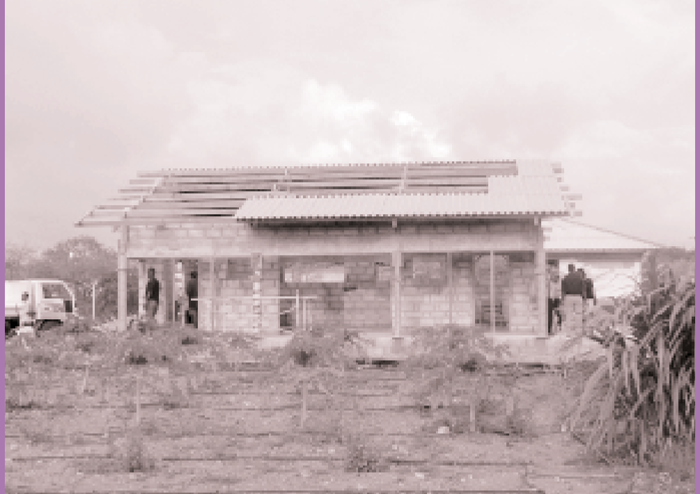
De opslagplaats in aanbouw ▶
