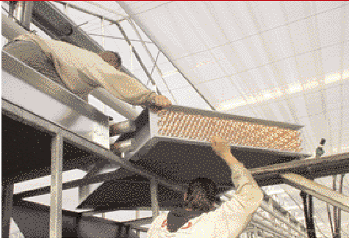
Vooral de mate van koeling beïnvloedt de kostprijs; het koelen met 700 Watt per m 2 is ongeveer drie keer zo duur als het koelen met 50 Watt per m 2 .
