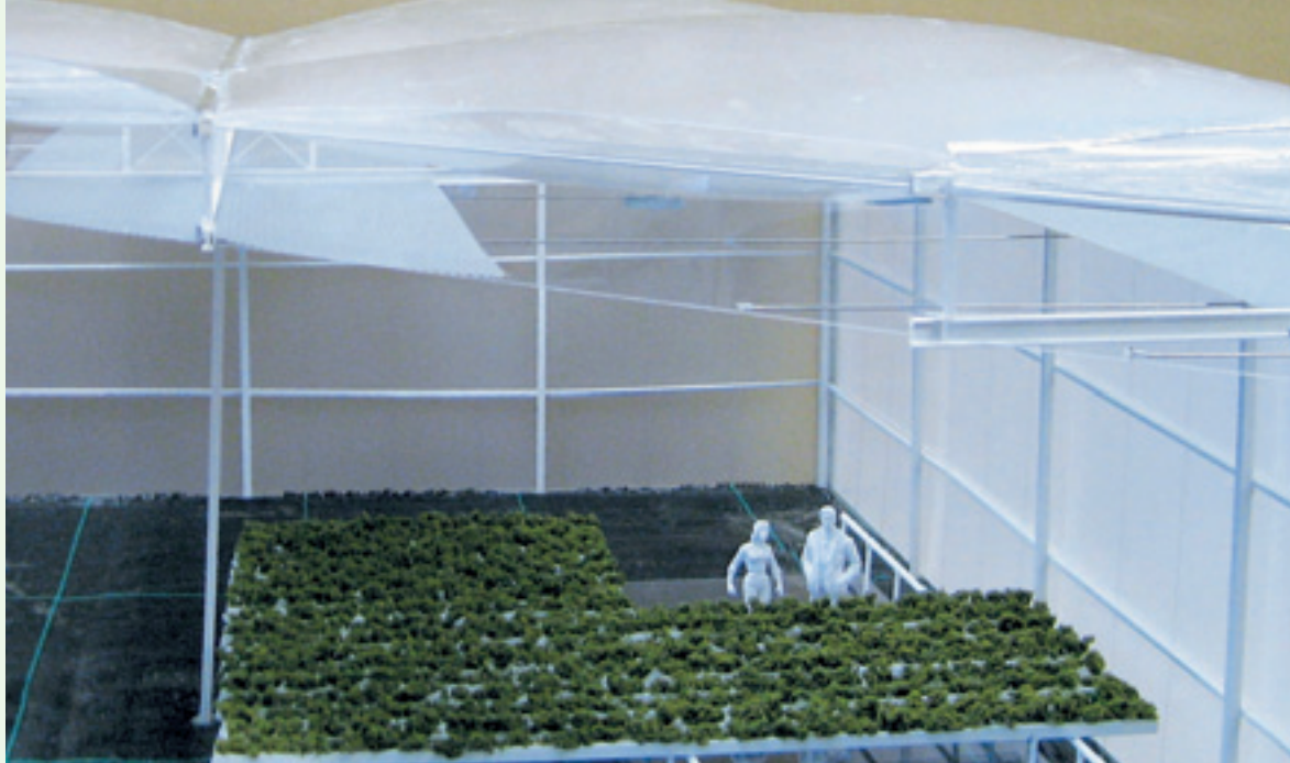
Artist impression van de dampdichte Crops 07, waarin luchtramen ontbreken. De gekoelde kasvloer is een belangrijk kenmerk van het Crops-concept.
