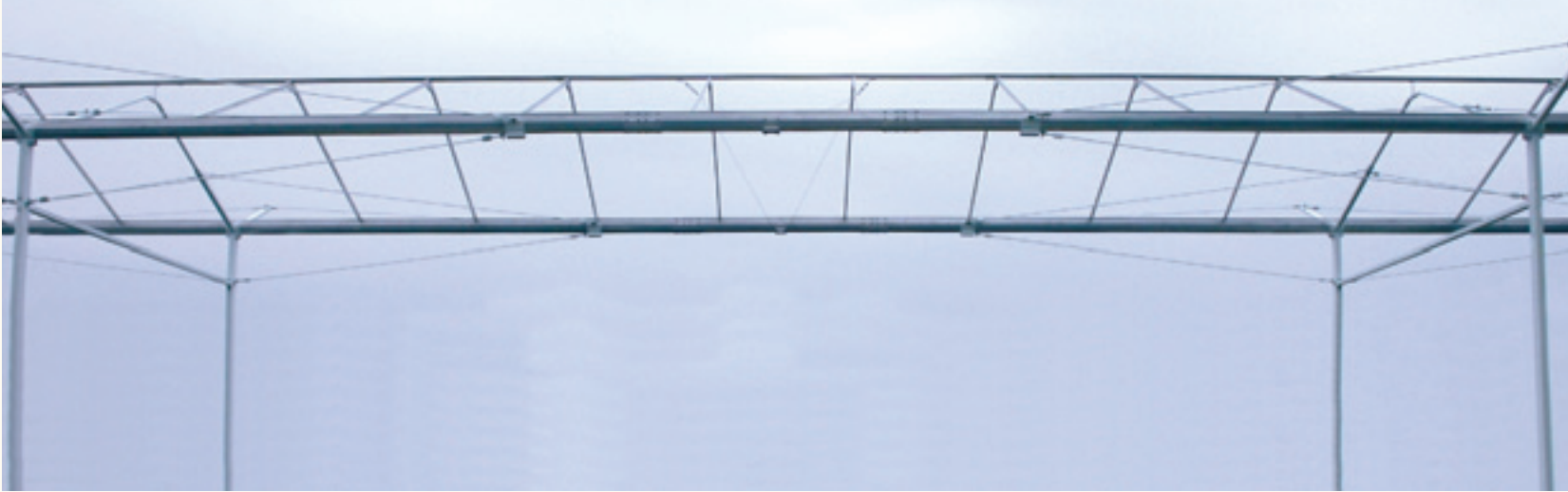
Een zijaanzicht van de kap met trekstangen, waarbij de grote vrije overspanning goed is te zien.
