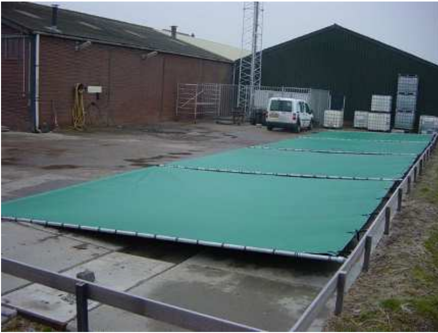
Foto 2: Aangepaste schoonmaakplaats bij Loonbedrijf Hoogland met opvangput en afdekmogelijkheid
