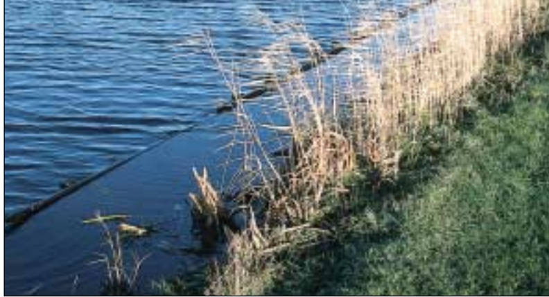
Aqua Flora-rol: een rol met waterplanten wordt aan de bestaande beschoeiing gehangen.
