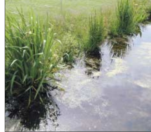
Amevo-type: een voorgegroeiende mat met waterplanten wordt op het talud aangebracht.
