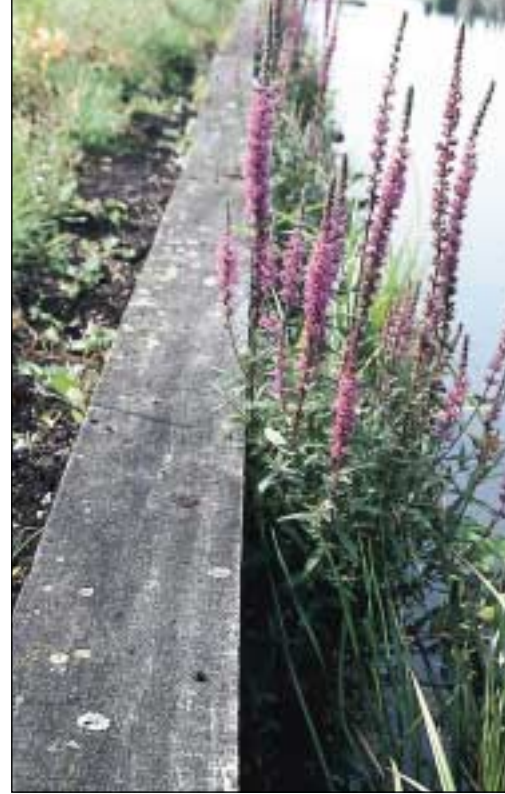
Het baggertype: een vooroververdediging met vurenhouten schotten. De ruimte achter de schotten wordt opgebaggerd en ingeplant.
