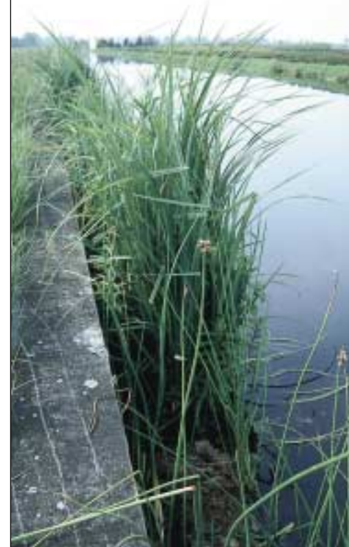
Amevo-type: een voorgegroeiende mat met waterplanten wordt op het talud aangebracht.
