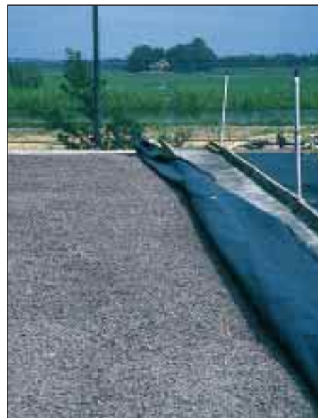
Drainerende ondergrond met lava zorgt voor een goede waterafvoer.
