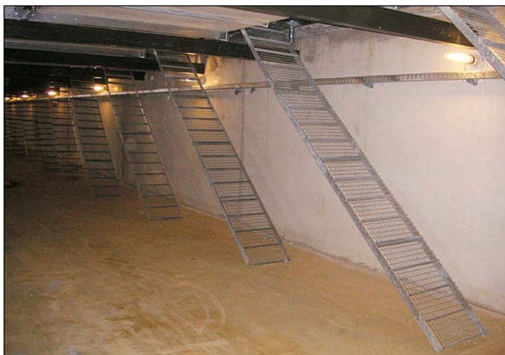
Figuur 3 Onderste etage met de betonvloer voor de strooisellaag en rechts de looptrappen voor de kippen (Bron: brochure fabrikant)
