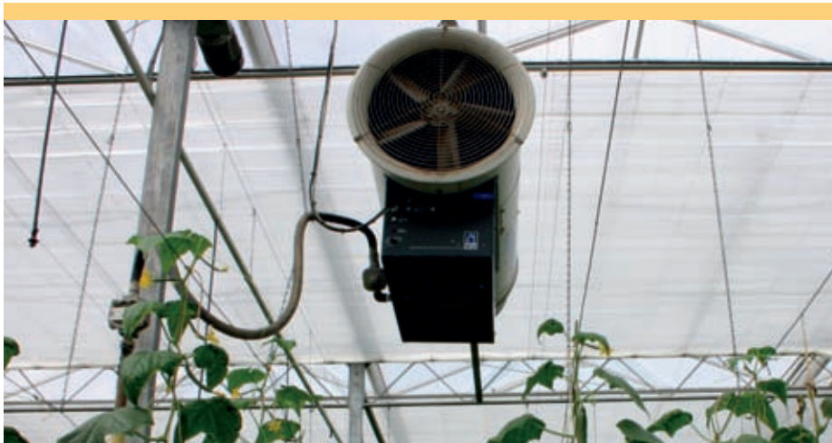
Teler Reijm stuurt de heteluchtkachels apart aan voor een gelijkmatige gasafname. Hij heeft daardoor zijn contractcapaciteit fors kunnen verlagen.
