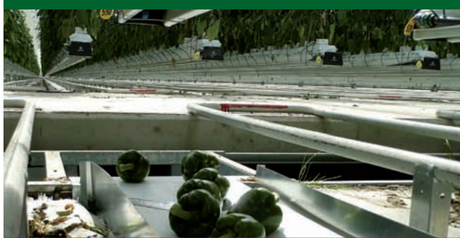
Onder elke tweede goot ligt een 'gootprofiel' waarop een sleepband ligt. Deze sleepband loopt van gevel naar gevel over een afstand van 250 m.
