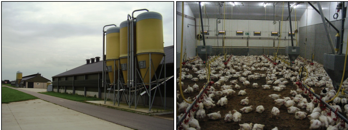
Figuur 1 Stal P1 van praktijkcentrum Het Spelderholt te Lelystad. Links: de buitenzijde van stal P1. Rechts: het voer- en drinkstelsel en de inlaatkantelkleppen en radiatoren aan de zijwand
